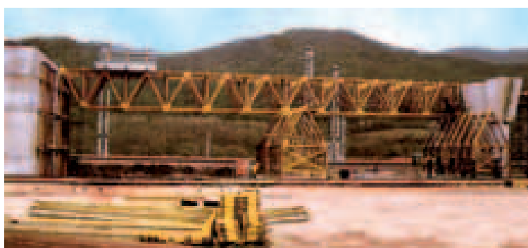
Cercha MK en ejecución de puente en arco
