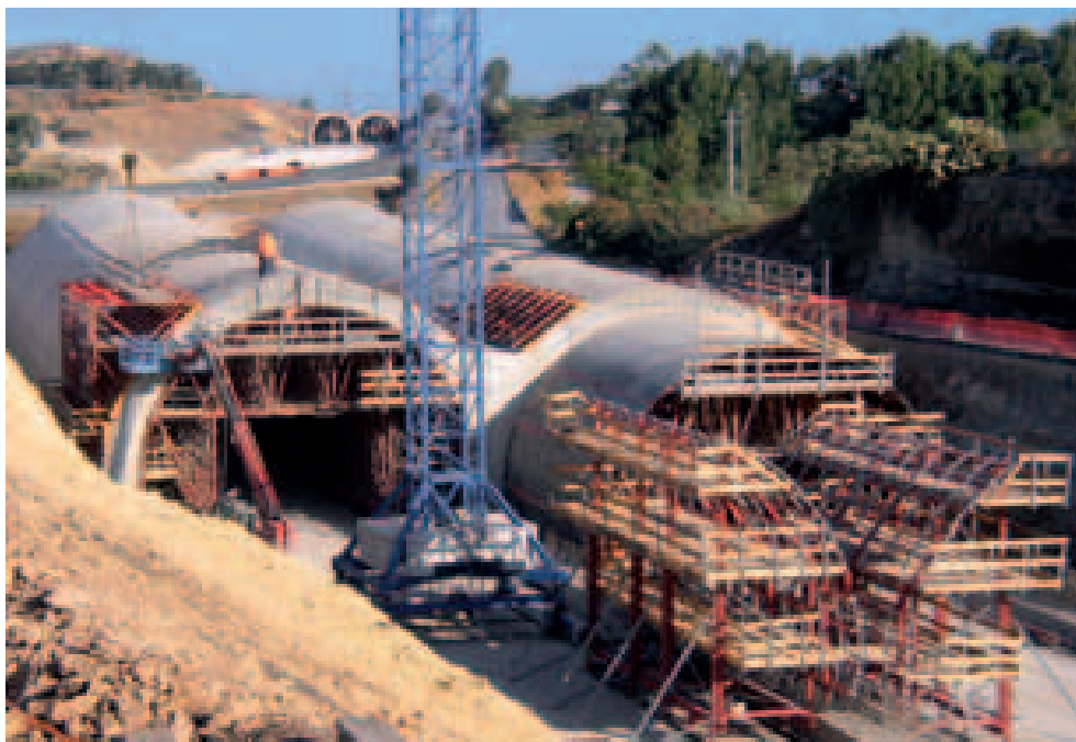
Falso túnel ejecutado con Estructuras MK
