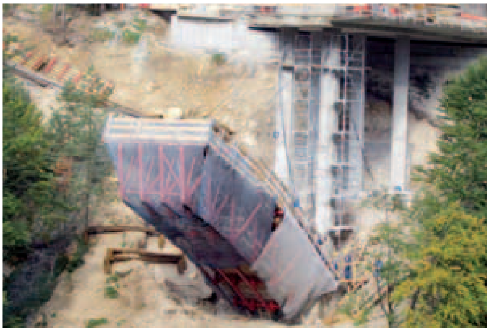
Cercha MK en ejecución de puente en arco
